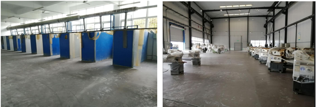
实验室场地改造和设备搬迁调试工程施工现场
